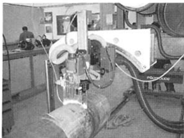
图 11 超超临界锅炉二级混合器的窄间隙热丝 TIG 焊
