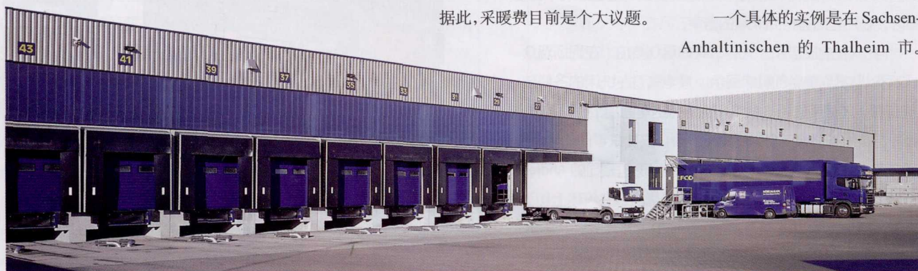
图2 如今装卸系统非常畅销，可以对载重汽车与装卸站台之间进行良好的隔离，特别是在寒冷的季节帮助节能
