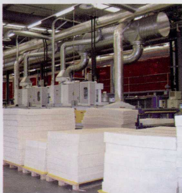
图4 整个床垫巡回周转的流程由60个单独工位构成，分布在两层楼的生产厂房内。上层是橡胶硫化隧道，下层是上料、装模、出模和模具冷却通道
