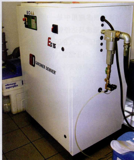
图 2 经过干冷器处理的压缩空气为满足实验室的使用要求还要再经吸附式干燥器处理
