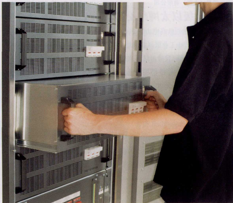
图2 模块化不间断供电设备可以灵活地进行补充装备。在发生事故情况下，故障模块在几分钟之内就可更换，而不必使整个设备停止运转
