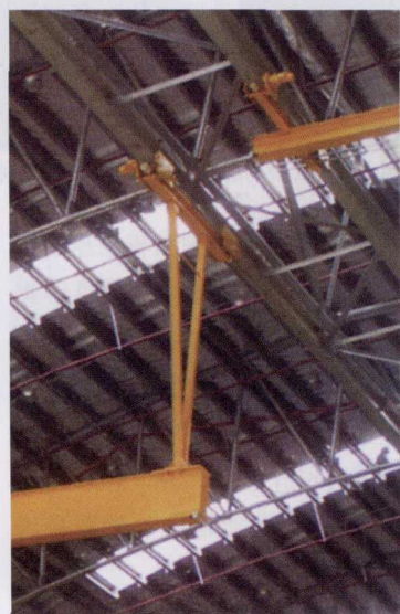
图3 6 m长的悬吊装置，保证15 t起重机的安全
