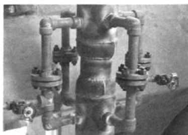
图5 联络管安装焊接
