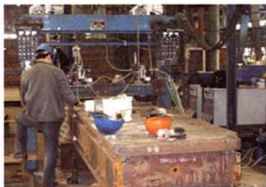
图2 非熔嘴式电渣焊施焊实景
