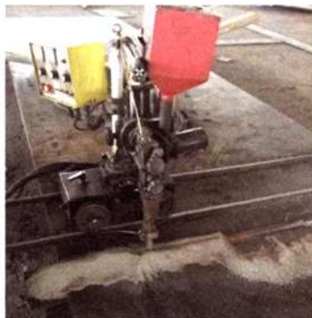
图1 埋弧焊接实景
