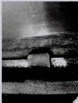
图3 同台火焰筒定位块焊点情况
