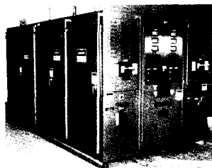
图1 封闭的电源柜
