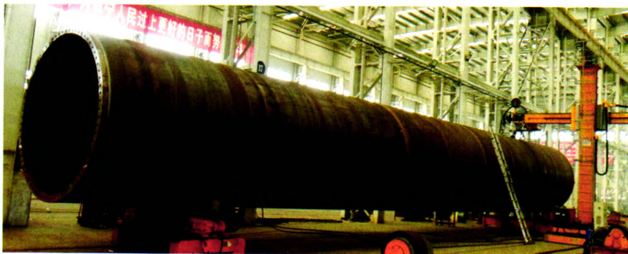
环缝外侧焊接
