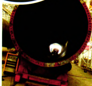
环缝内侧焊接
