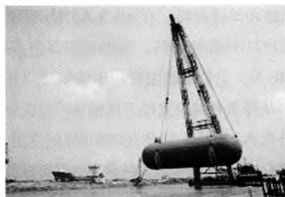
图 6 储罐外部做完绝缘后吊装上船过程
