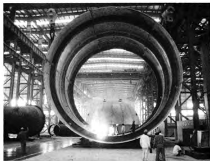
图2 筒节与筒节组焊后焊接过程
