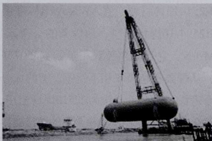
图 6 储罐外部做完绝热后吊装上船过程
