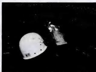
图7 内坡口焊接技巧
