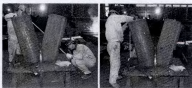
图5 依据起割点对圆管柱定位
