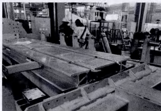
图4 枕梁正装夹紧
