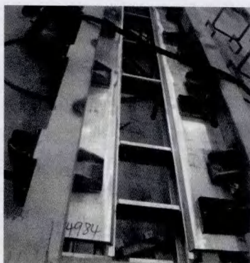
图5 枕梁反装夹紧焊接
