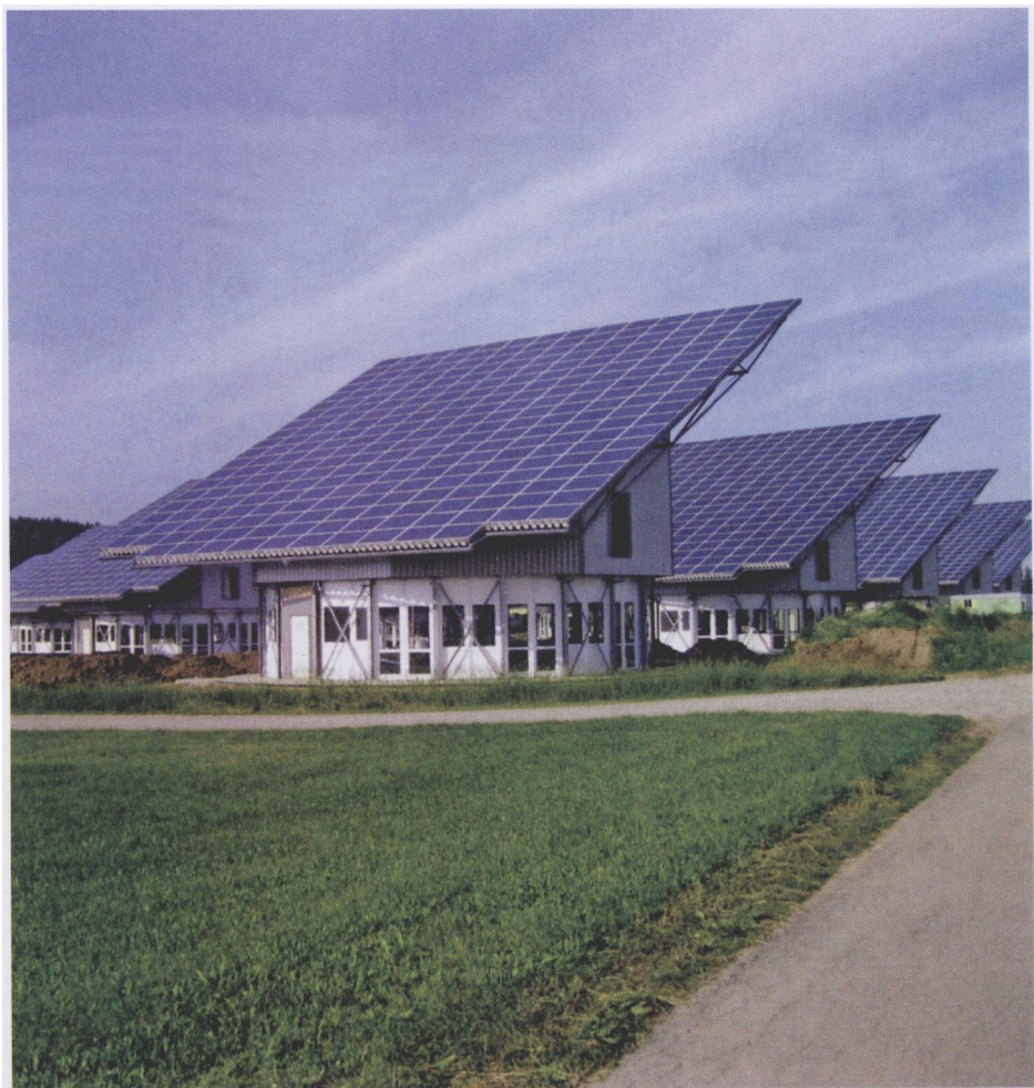
◀ Westenheim 科技工业园里的光伏太阳能发电设备采用了自动光源跟踪技术，安装了4个齿圈直径12m的PV光伏太阳能旋转装置和各300m 2 的太阳能收集器
