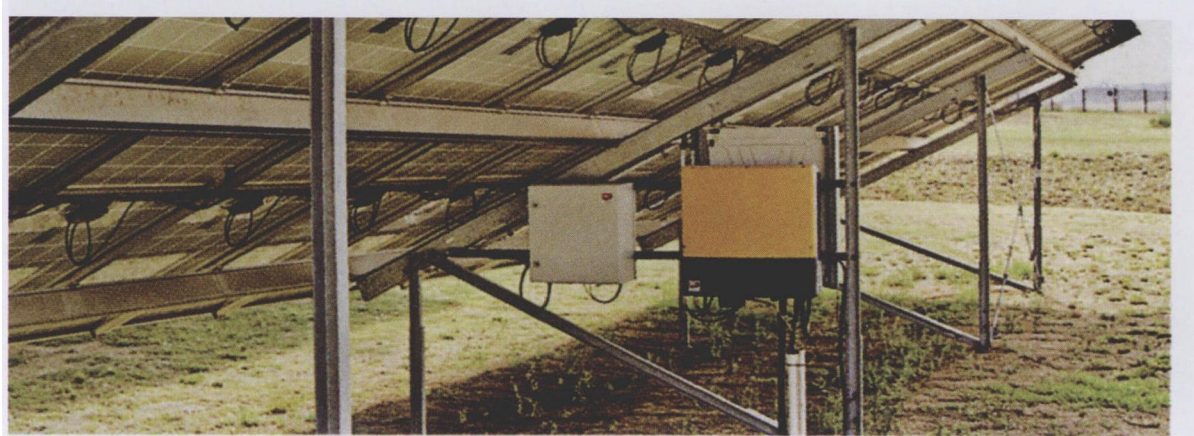
采用太阳能镶板专用支架，可大大缩短设备的组装时间
