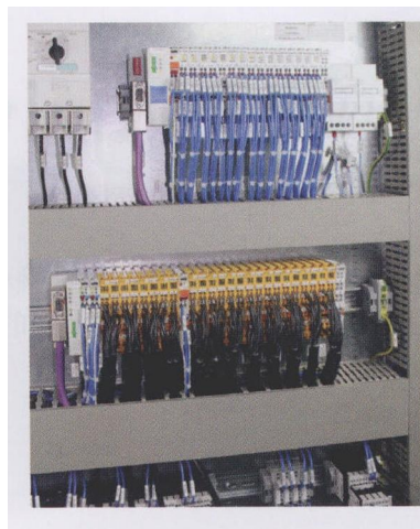
图 2 使用 WAGO PROFIsafe 模块，安全相关信号与非安全相关信号均通过同一个现场总线进行通信。在同一个节点中，安全模块和普通非安全模块可以混用
