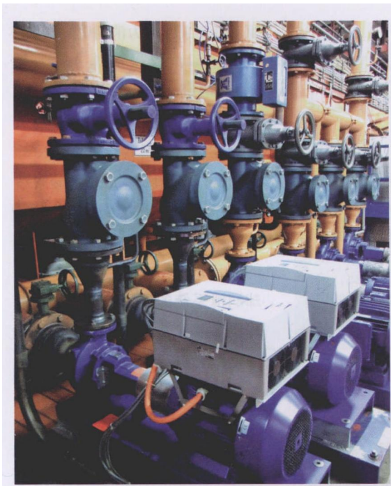
图1 改造后的冷却润滑站可利用转速调节装置自动根据各个磨削机床对冷却液的需求提供冷却液
