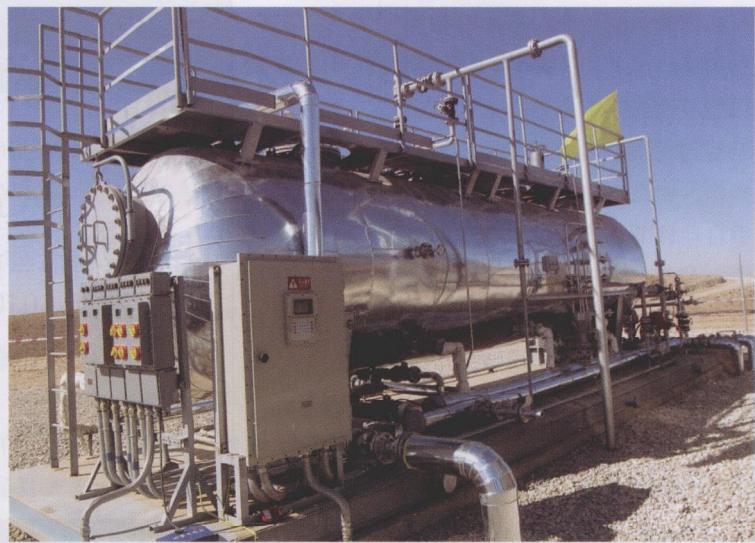
机箱采用带小屏显的防爆机箱
