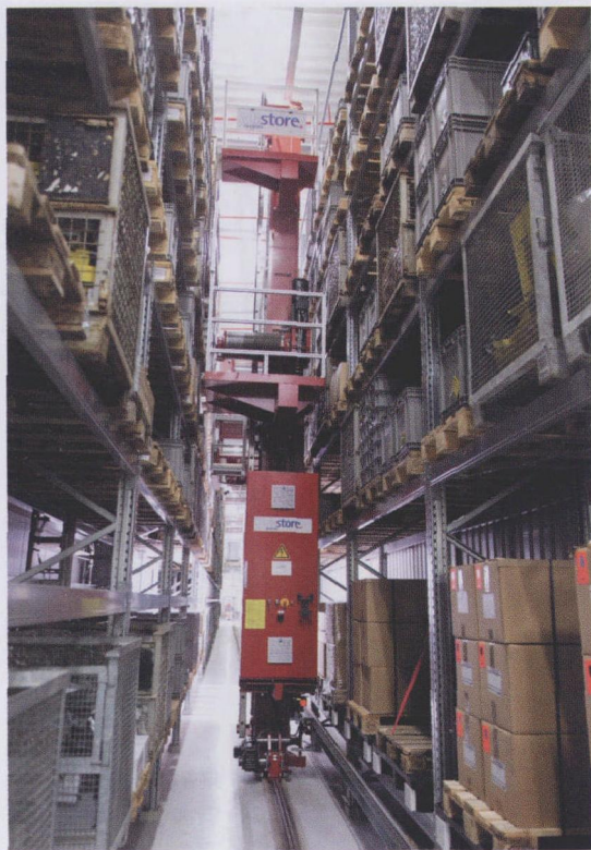
图1 PowerTop 装配区的输送机能确保维护工作在不进入通道的前提下完成
