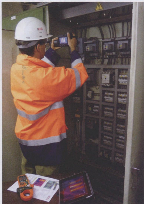
图 1 为了在密闭空间内拍摄热图像，Michael Weight 在其 FLIR T440 上另外安装了一个可互换的 45° 广角镜头
