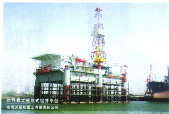
图4 山海关船厂世界最大底座式钻井平台
