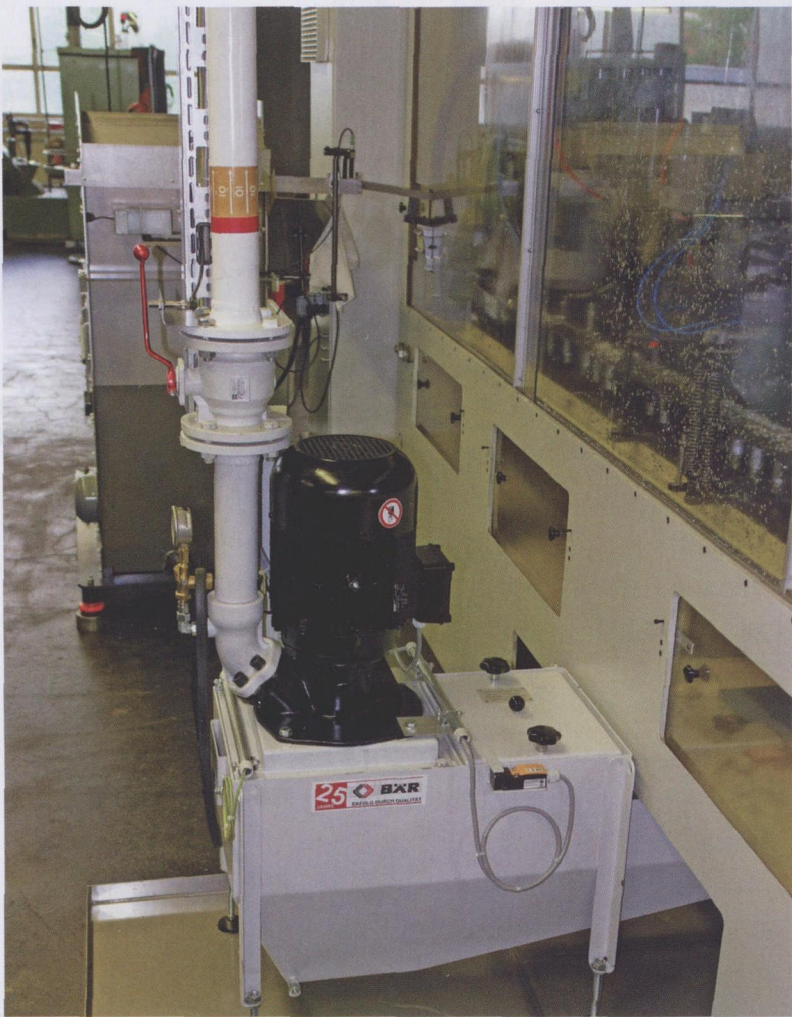
图 1 用可切碎刨屑的泵将冷却剂和切削机油直接输送到中央净化处理装置
