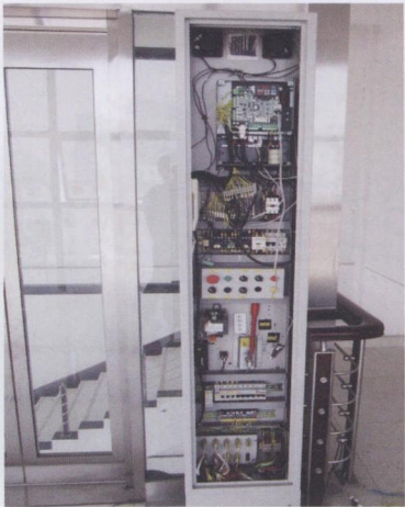
图 5 现场测试照片
