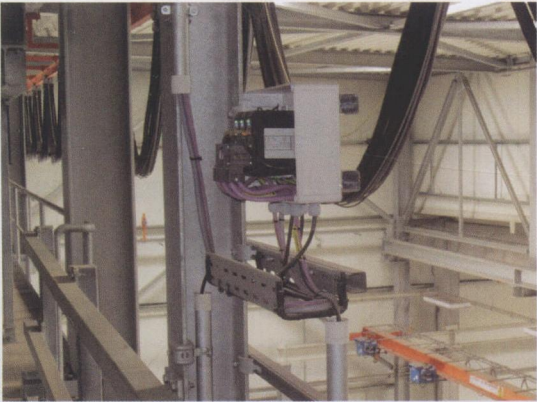
图 3 起重设备处的无线通信模块
