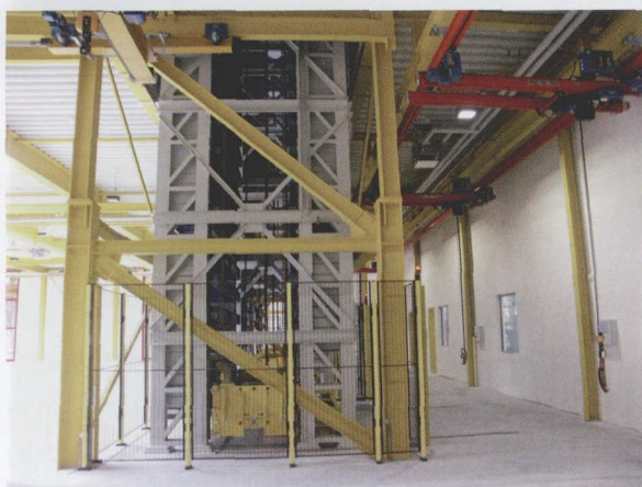
图5 Paul Henke Möbelbeschlagfabrik 家具五金配件厂的三套 Intertex 公司的 Tower-Mat 系统分别安装了 61 个模具盒
