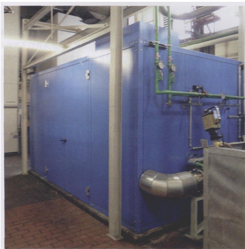
在 V-Major 活塞式空气压缩机的基础上改造的压力放大器可以将 0.6 MPa 压力的压缩空气提高到 1.2 MPa
