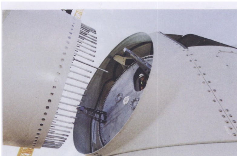
图3 直径为 \phi 154\text{ m} 的大型风力发电机转子叶片准确地吊装到机舱上
