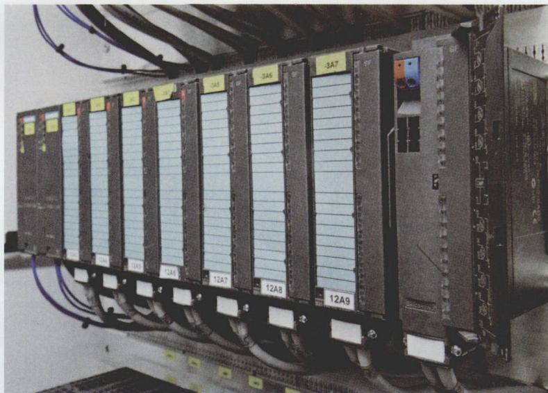
图 5 去掉连接头上的短接插线后可以毫无影响地安排模拟信号
