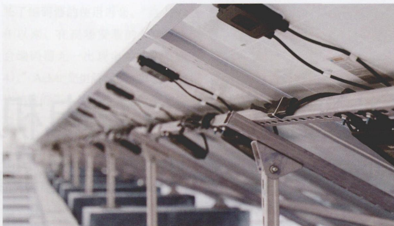
图2 在每一块太阳能光伏面板的下方，都能发现菲尼克斯电气 AC-Y 型连接器的身影：一端连接着微型逆变器，将微逆变换出的交流电传输到 AC-Y 型连接器主干线，若干主干线之间再进行耦合连接，使得各微型逆变器转换出来的电流能够并入电网
