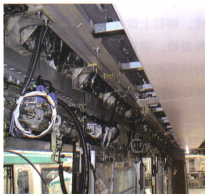
图8 北京地铁4号线车顶
