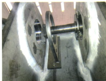
图4 安装支架工装
