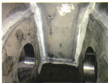
图3 加工安装螺纹孔
