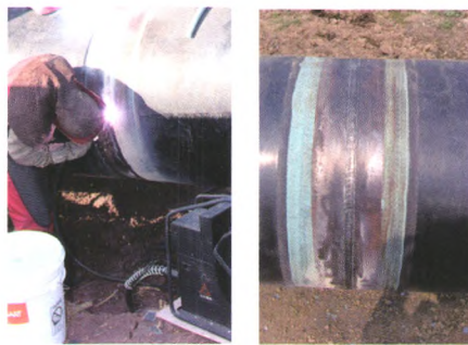
图9 多功能焊机药芯自保护焊盖面效果
