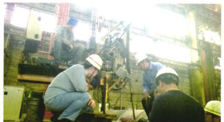
图6 丸山先生和我公司人员在现场焊接试件
