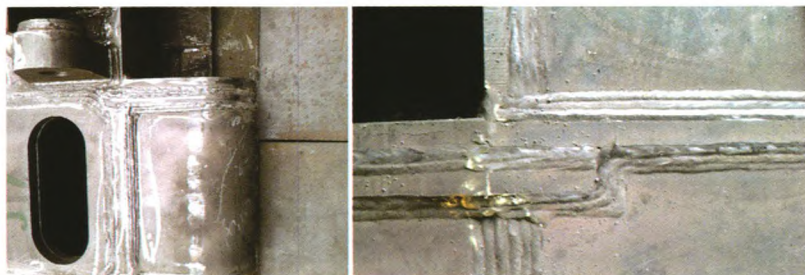
图4 液压支架的多层多道焊缝
