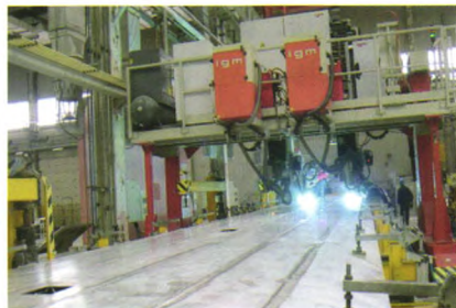
图5 龙门式IGM机械手的双焊枪同时焊接车顶外侧焊缝
