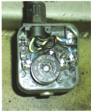
图3 前室压力开关
