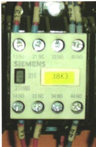
图2 吸合的前室压力开关继电器
