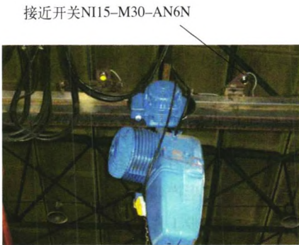
图6 电葫芦及控制开关
