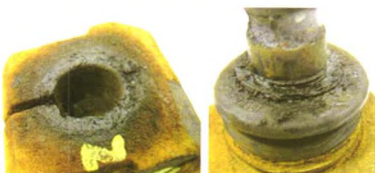
图4 密封试验后转向节配合面锈蚀
