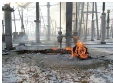
图4 5033A相电流互感器损坏着火
