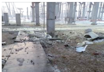
图5 5033A相电流互感器瓷瓶散落
