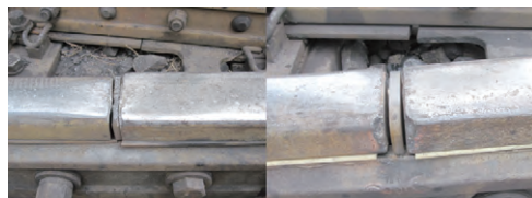
图1 正常的轨道绝缘 图2 烧蚀的轨道绝缘
