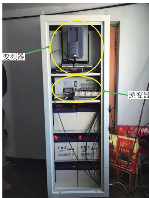
图4 离网型风光储供电系统背面图
