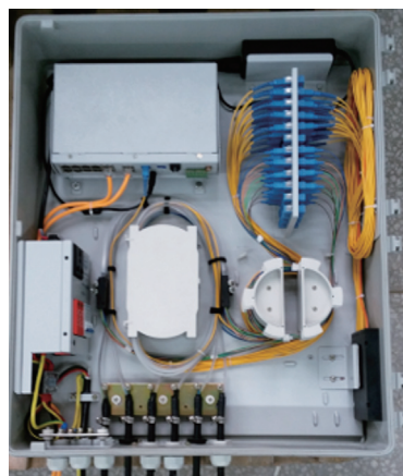
图2 光电综合箱实物
