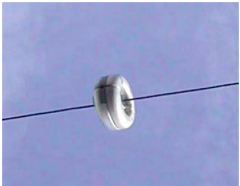
图 2 Power - Donut2 的安装使用
