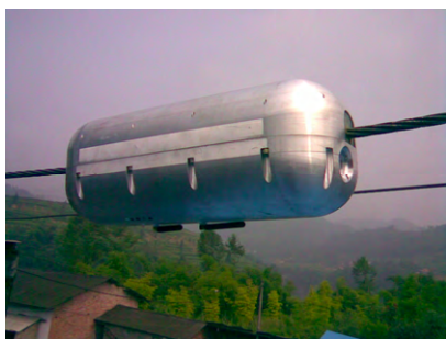
图 4 国内高压耦合取电装置安装示意图 1
