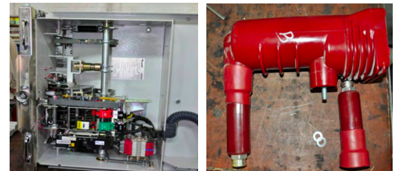
图 6 开关柜机械结构和断路器极柱外观照片
