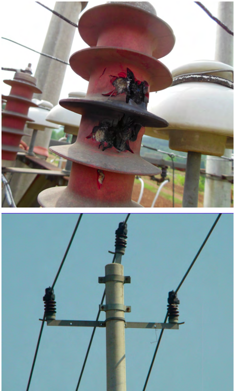
图 1 避雷器、绝缘子遭雷击造成故障
