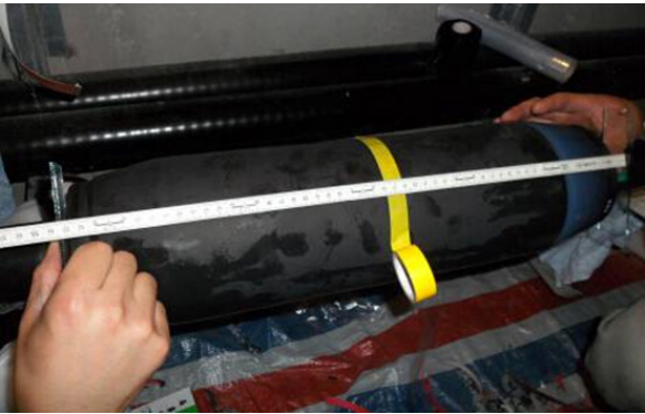
图13 现场应力锥套入位置后尺寸
