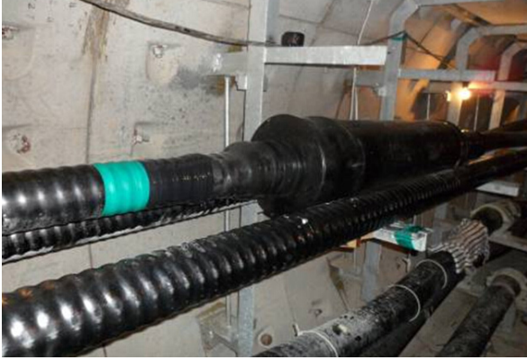
图15 现场附件整体装配相片
