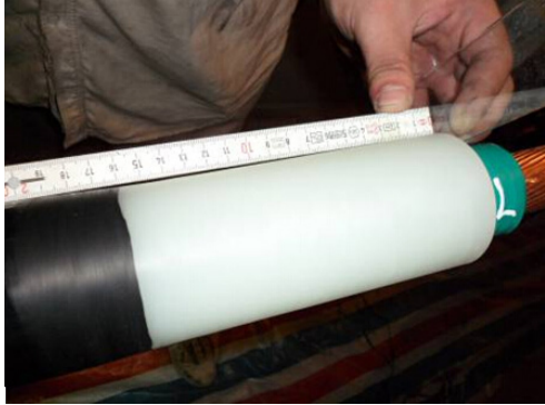
图10 现场电缆绝缘层尺寸
