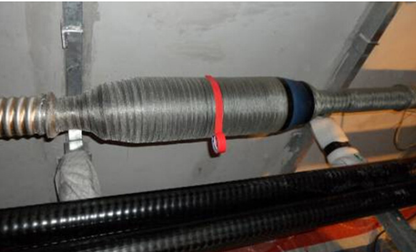
图14 现场绝缘接头应力锥包铜网相片
