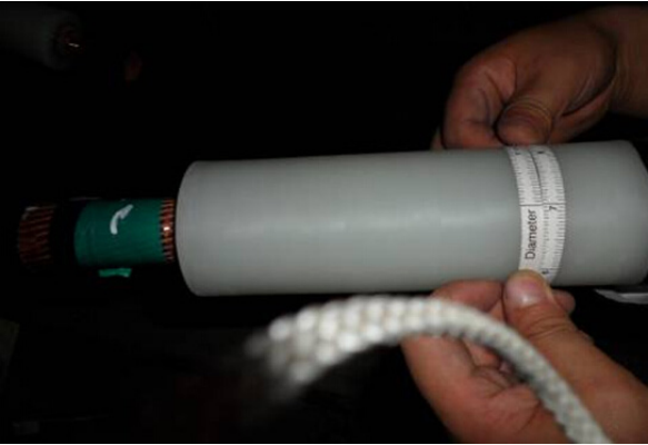
图11 打磨后绝缘直径
