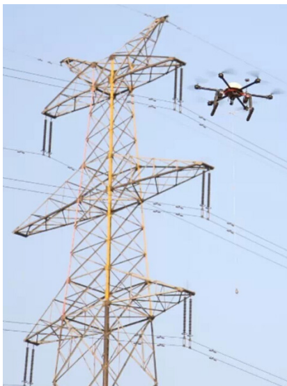
图3 直升机进行线路架设
